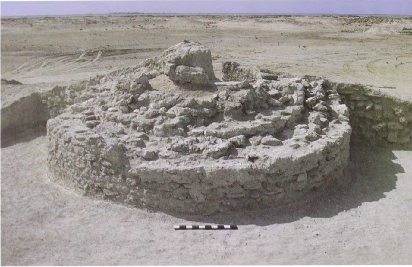
الزبارة - أحد أبراج السور الخارجي للمدينة المدعم قبل إجراء أعمال الترميم
